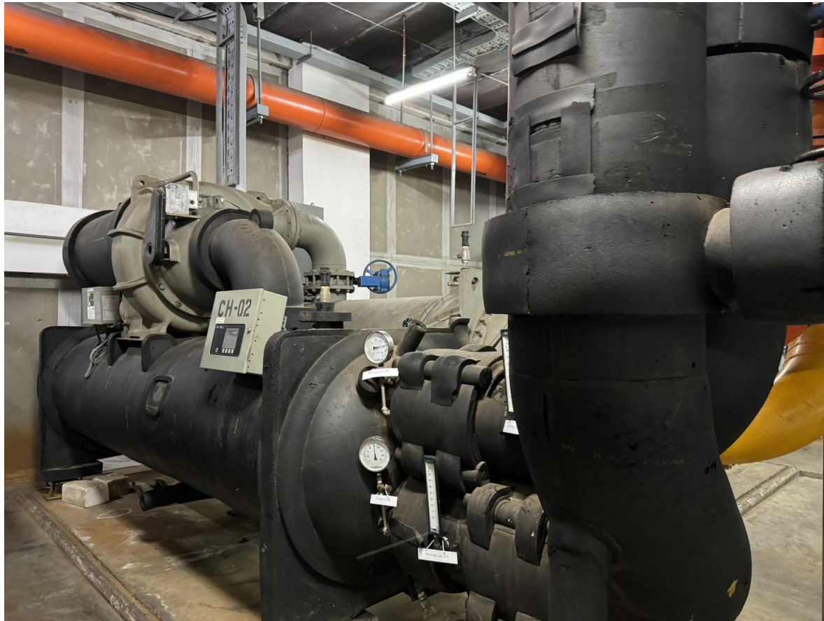
Replacement Chiller 600 TON
